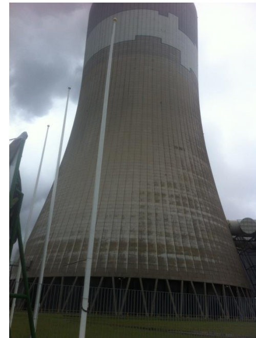
Elektrownia PGE Bełchatów
